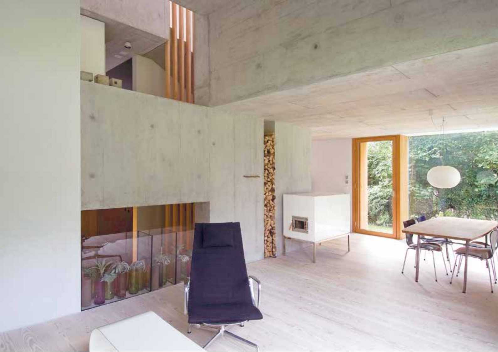
Ein Kleinspeicherofen im Wohnraum eines Einfamilienhauses.
